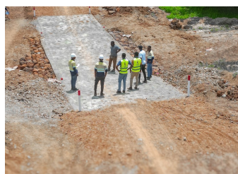
Radier submersible de 20 ml offert au village.
